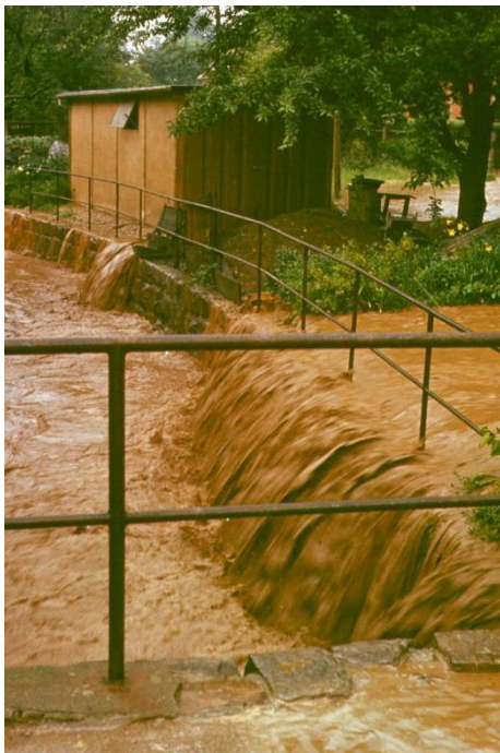
Abbildung 64-1: Foto Bürgerinitiative: Überschwemmung, Wassermassen in den Unritzbach
